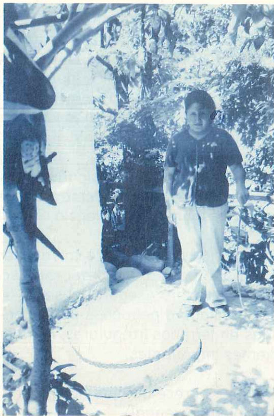
Pozo de revisión en una casa de Llacao
