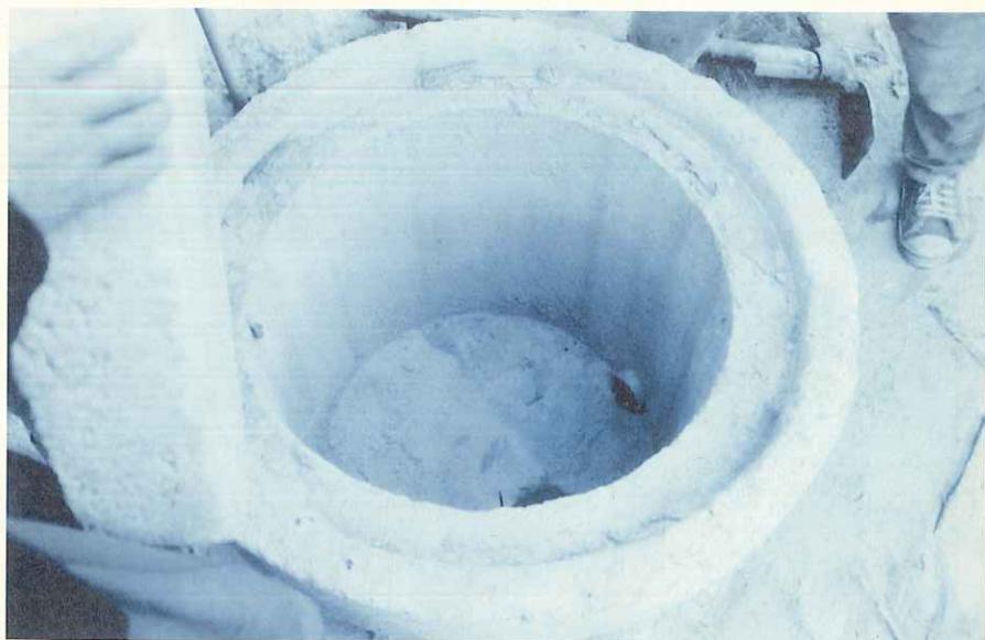
Pozo de revisión domiciliaria
